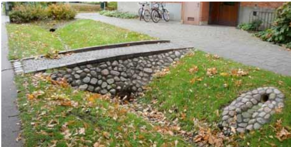
Figur 30. Fördröjningsmagasin som är utformat som svackdike. Gångbroar kan fungera som barriär för skiljning mellan trappstegsmagasins olika sektioner. (Källa: Dagvattengruppen Sweco).
